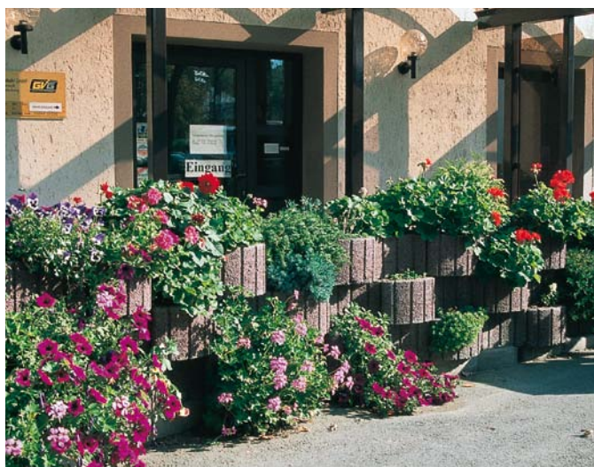
Zbocze – układ przesunięty. Kształtki ustawione są na przemian w kierunku podłużnym i poprzecznym, przez to tylko co drugi pierścień można obsadzać roślinami.
