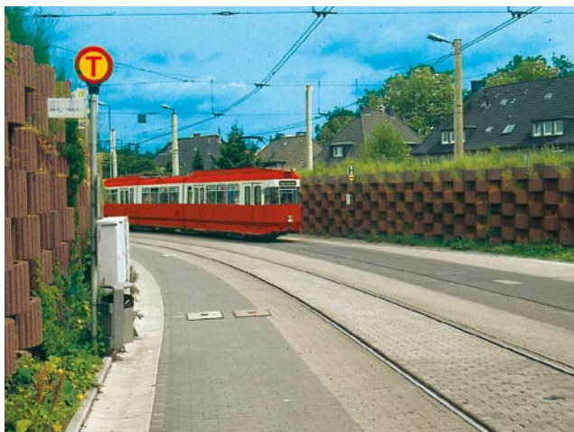
Ściana z kształtek LUSAFLOR jako ekran akustyczny wzdłuż torów tramwajowych.
