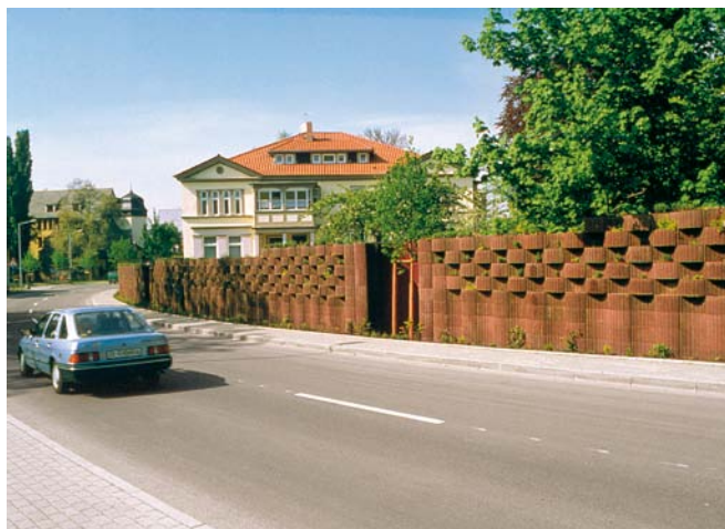
Ściana z kształtek LUSAFLOR w mieście, przy ulicy jako ekran akustyczny. Widoczna wykonstruowana wnęka na rosnące drzewo.
